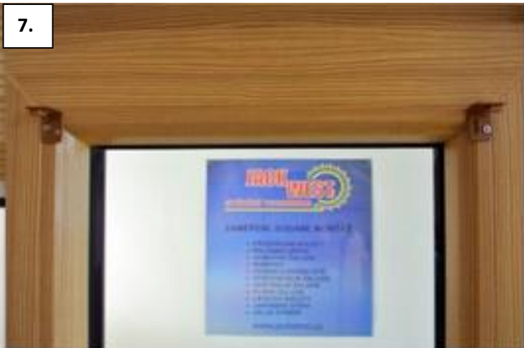
Pohled na připevněné montážní úhelníky (vrchní část).
