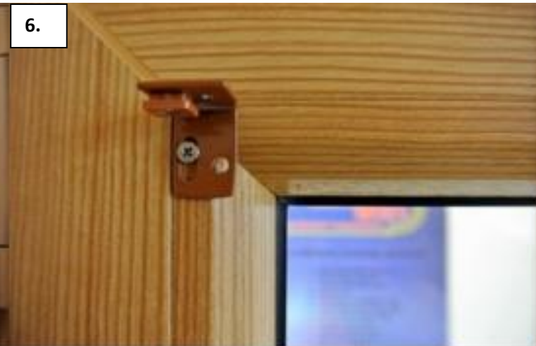
Připevněný montážní úhelník šroubem.
