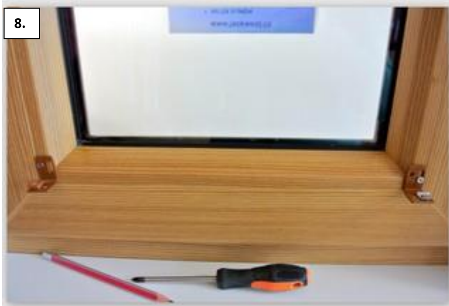
Pohled na připevněné montážní úhelníky (spodní část).
