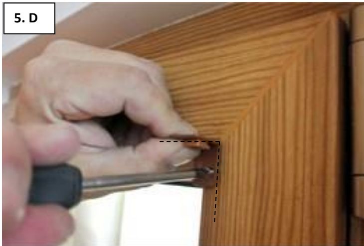
Šroubem přichyťte montážní úhelník a totéž proveďte ve zbývajících 3 rozích.
